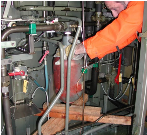
Abb. 1 Instandhalter bei Wartungsarbeiten
